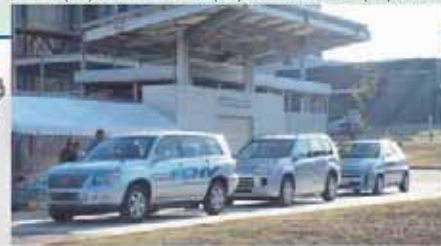
九州大学・水素ステーション
