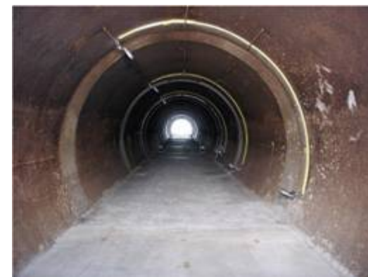
図 ダクト内部
