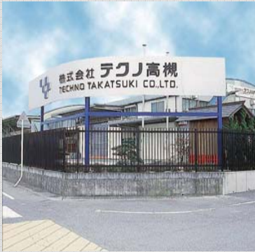
滋賀県蒲生郡 日野工場
