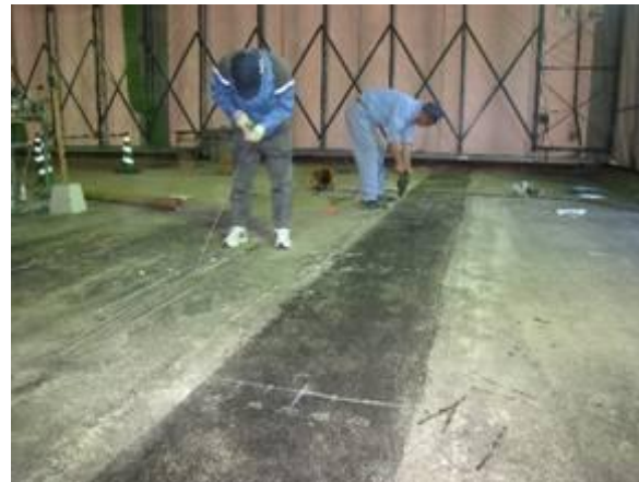
採取管打込み作業
