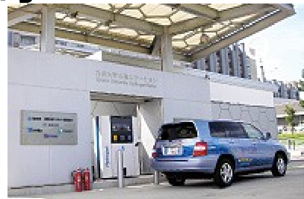
九州大学水素ステーション
