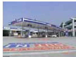
北九州総合エネルギーステーション
