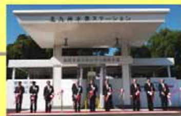
北九州水素ステーション (北九州市八幡東区東田)
