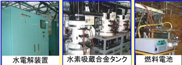
水電解装置 水素吸蔵合金タンク 燃料電池
