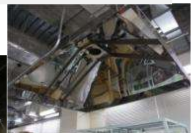
センサーによる 漏洩管理 一段警報1000ppm 二段警報2000ppm
