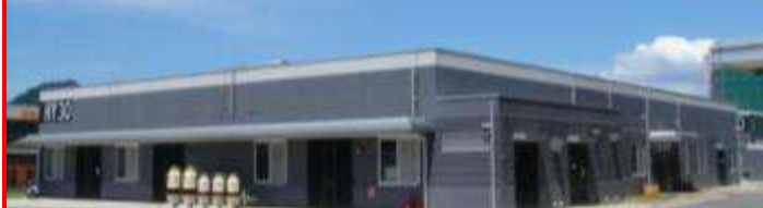
水素エネルギー国際研究センター
