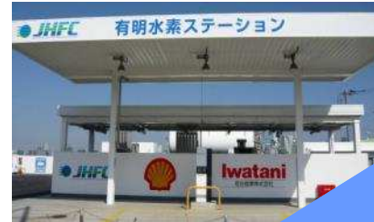
液水ステーション
