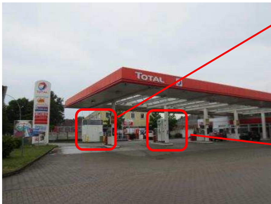
水素ステーション全景
