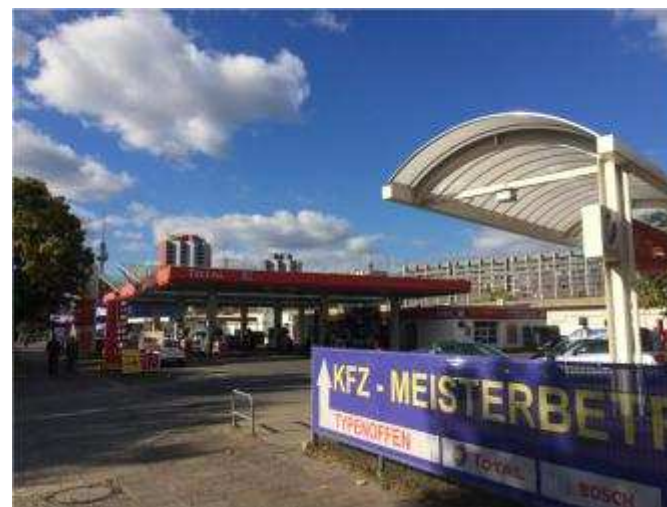
水素ステーション全景
