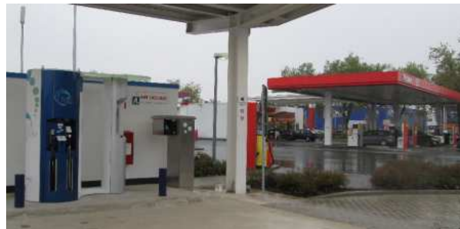
水素ステーション全景
