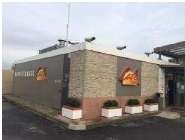
建屋内にIC90 (Linde製) を設置
