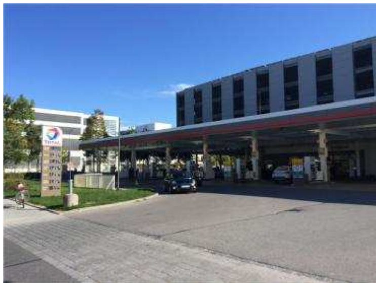
水素ステーション全景
