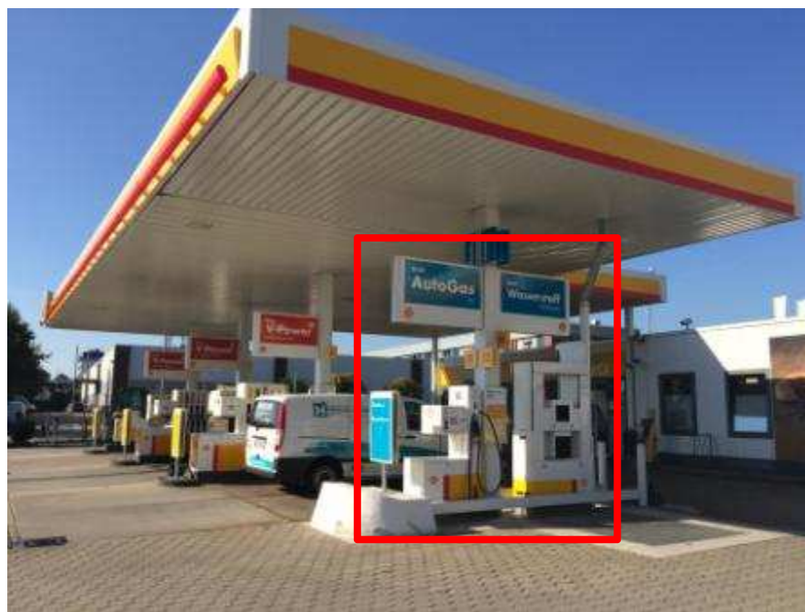
水素ステーション全景
