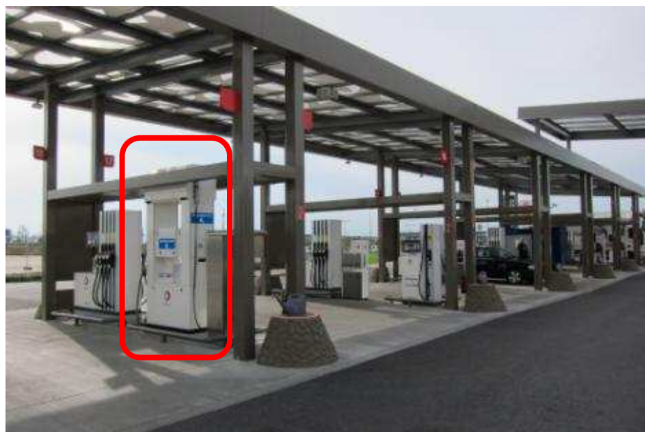
水素ステーション全景
