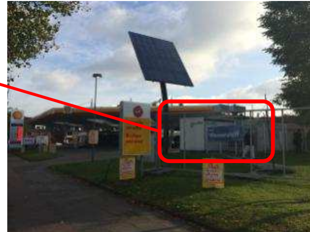
ステーション全景（併設ではなく、敷地の端に設置）
