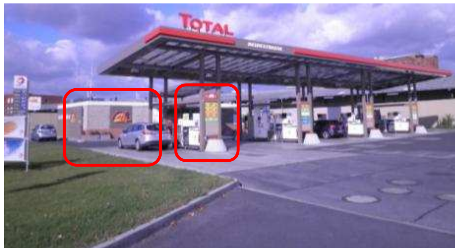
水素ステーション全景
