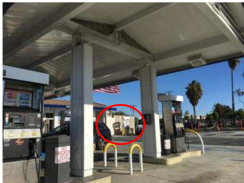
水素ステーション全景
