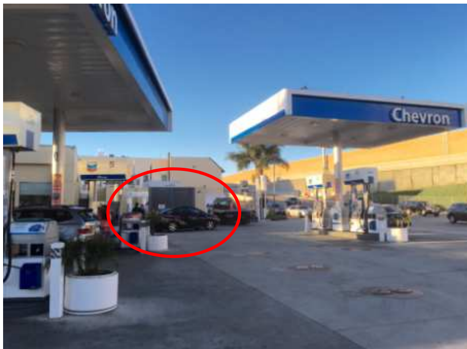
水素ステーション全景
