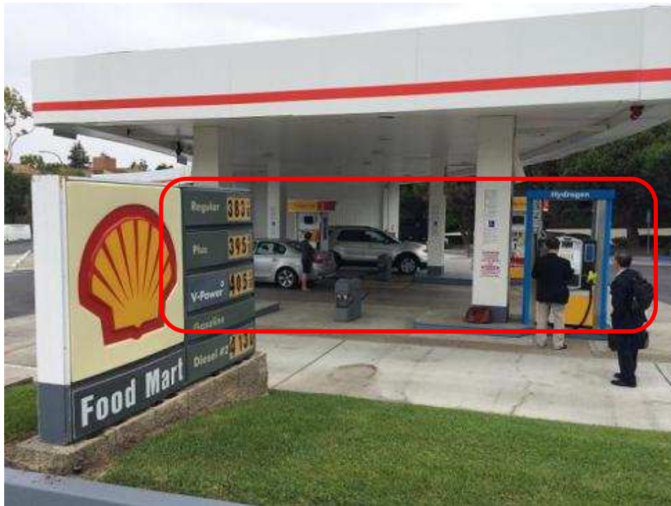
水素ステーション全景
