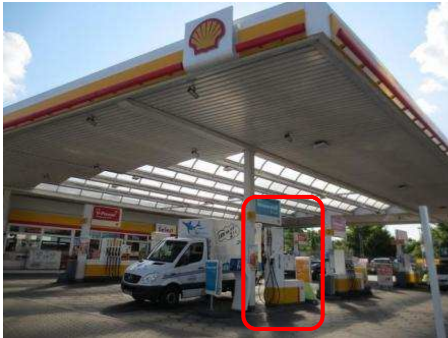
水素ステーション全景
