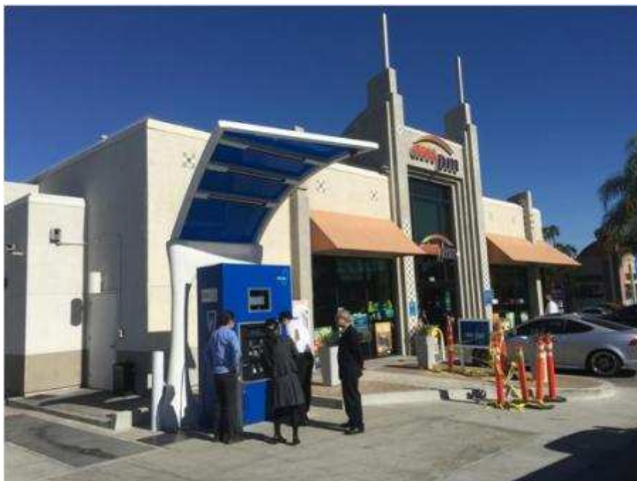
水素ステーション全景
