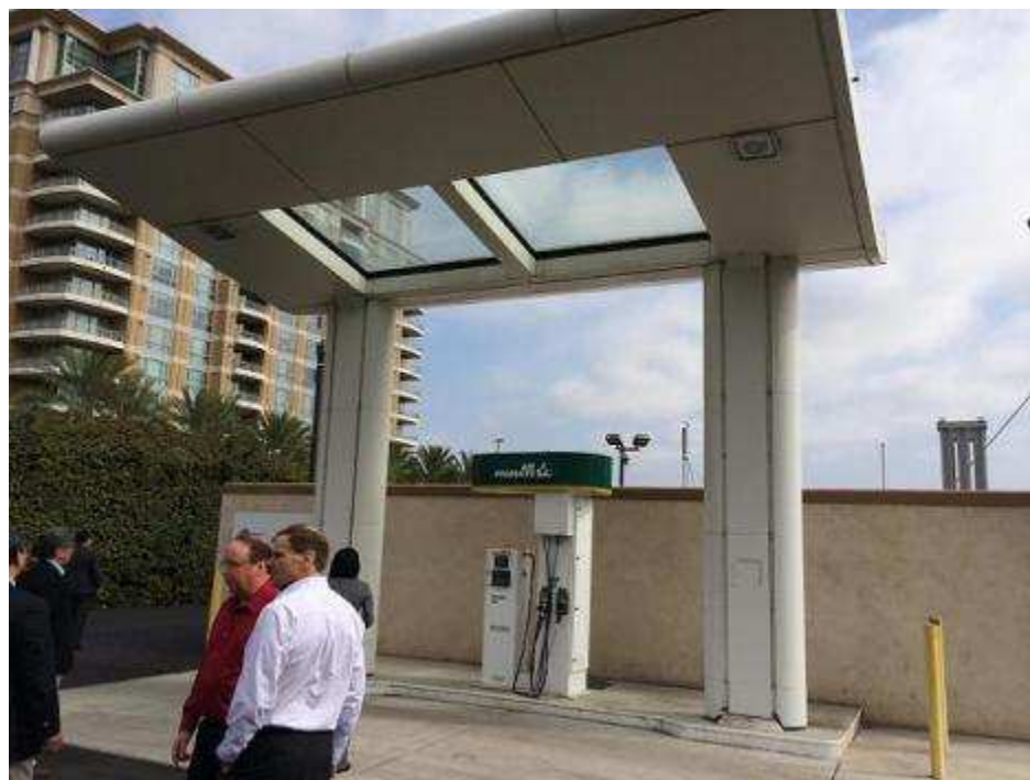
水素ステーション全景
