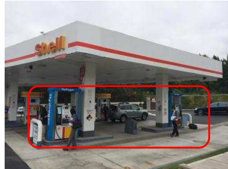
水素ステーション全景
