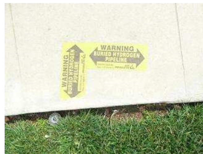
水素パイプラインの表示
