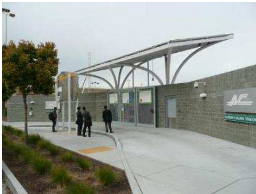
水素ステーション全景 (道路側から見た景色)
