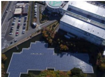
太陽インキ製造(株) 水上メガソーラー
